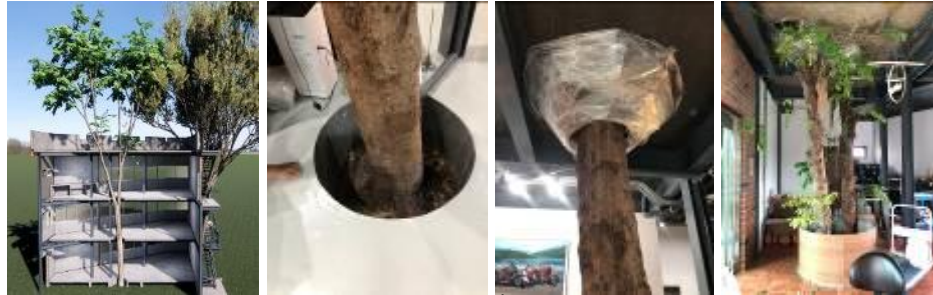
ภาพที่ 4 แสดงแบบขยายพื้นเจาะสำหรับไม้แดง
